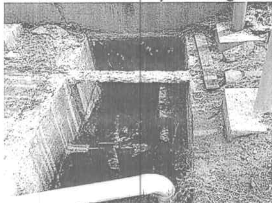
Foto 11. PTAR. 1. Tanque homogeneizador – 2. Canaleta 3. Tanque espesador
